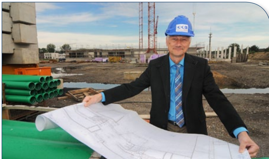
Landrat Wolfgang Spreen auf der aktuellen Großbaustelle des neuen Berufskollegs des Kreises Kleve in Geldern.
